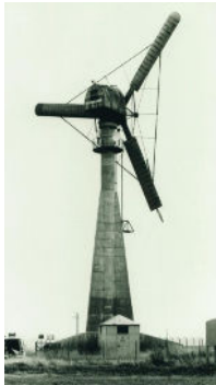
Gedsermøllen (1957) 24 m wingspan
